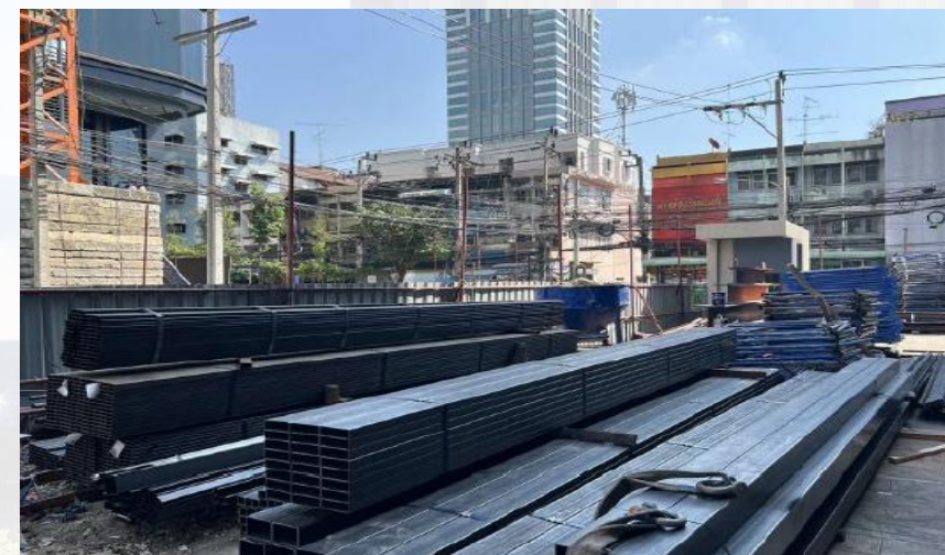
พื้นที่กองเก็บวัสดุ
