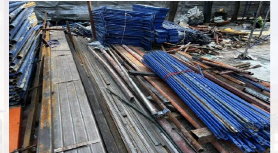
จุดคัดแยกเศษวัสดุก่อสร้าง
