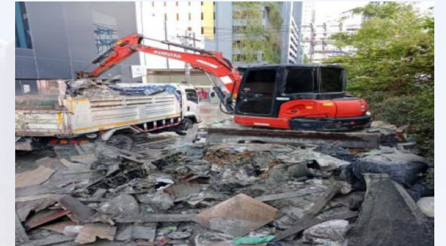
การขนย้ายขยะจากการก่อสร้าง
