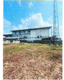
จุดติดตั้งที่ 2
